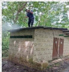
Ilustración 50. Limpieza de estructuras de la garita.
