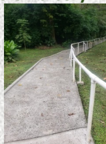
Ilustración 49. Limpieza del camino con hidrolavadora.
