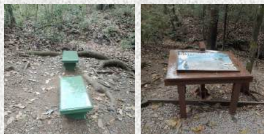
Ilustración 39. Limpieza y pintura.
