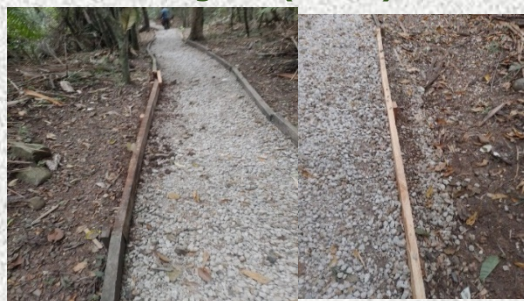
Ilustración 37. Estructura de los senderos.
