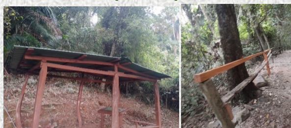
Ilustración 38. Reparación de rieles y pasamanos.
